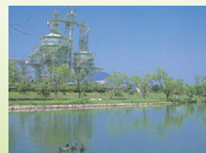
緑化を進めている雨水池周辺
