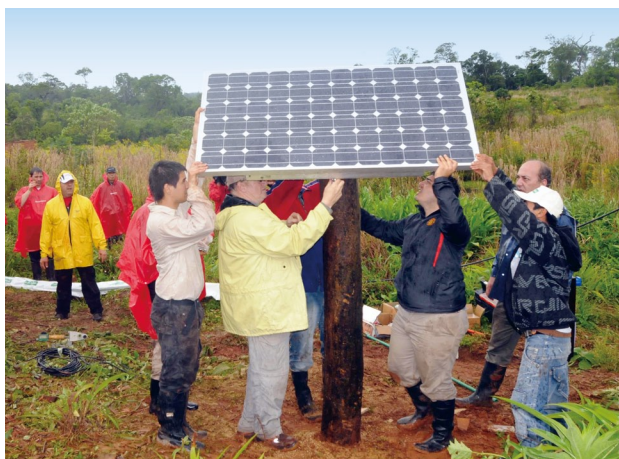
ソーラーパネルの設置
