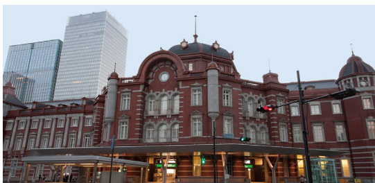
ブリヂストンの免震ゴムが採用された東京駅丸の内駅舎
