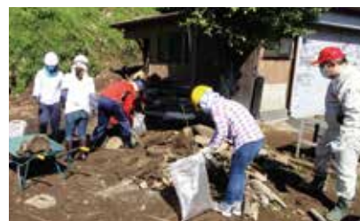
被災者住宅の土砂や瓦礫の撤去
