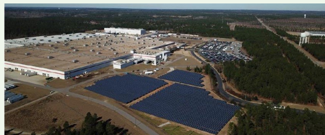
サウスカロライナ州エイケン郡 乗用車用・軽トラック用タイヤ工場
