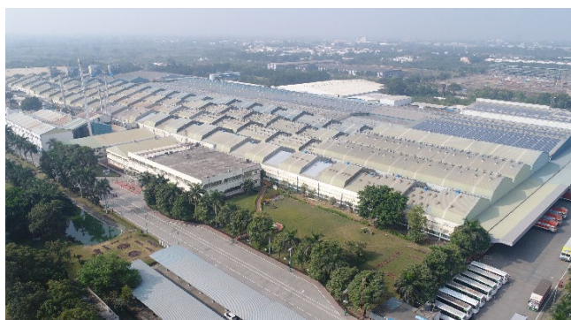
インドール工場
