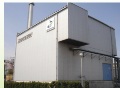
下関工場 コ・ジェネレーションシステム
