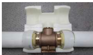
保温材に継手をセット
