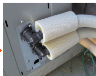
機器への継手接続／ 継手保温材を被せて施工完了
