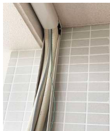
配管モールにヒートポンプ配管を入れる。
