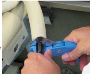
パイプカッターでホース切断 面取り不要!
