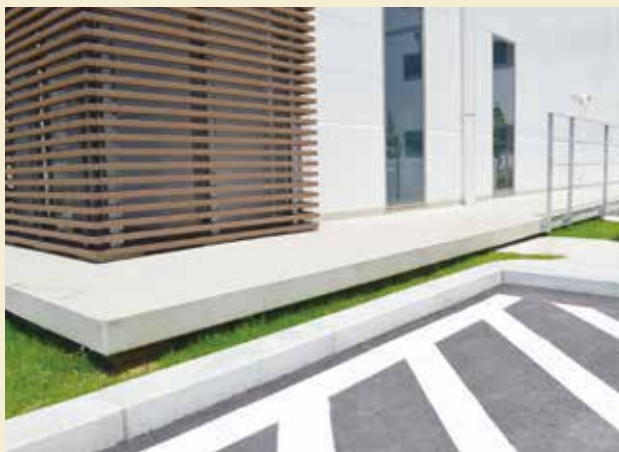
正面玄関横の免震クリアランス
