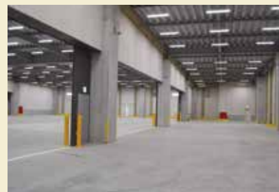
免震構造によって柱が少なく広い空間を実現 (写真のフロアは最上階)
