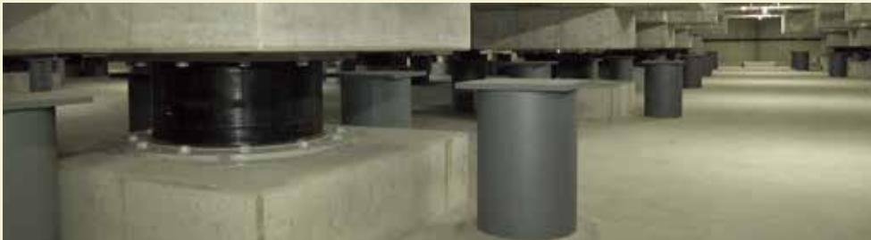
三越日本橋本店本館地下の免震ゴム 鉛プラグ入り積層ゴムと弾性すべり支承を合わせて314基の免震装置が13万トンの建造物を支えています。
