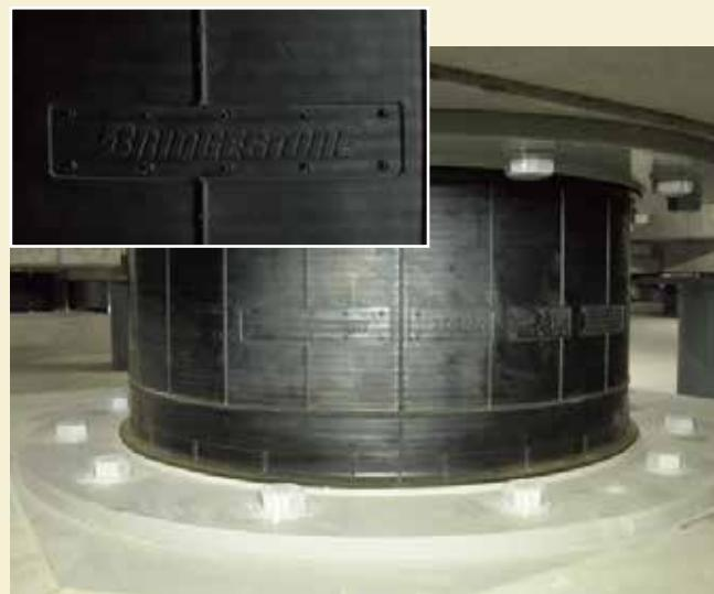
ブリヂストンの免震ゴム。薄いゴム層と鋼板を交互に積層した構造で、上下方向には硬く、水平方向には柔らかい性能を発揮します。
