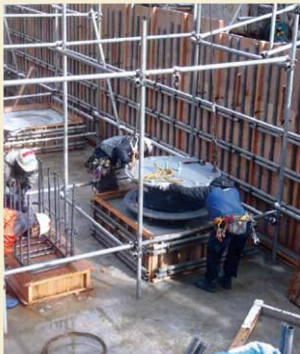
現場での据付工事の様子
