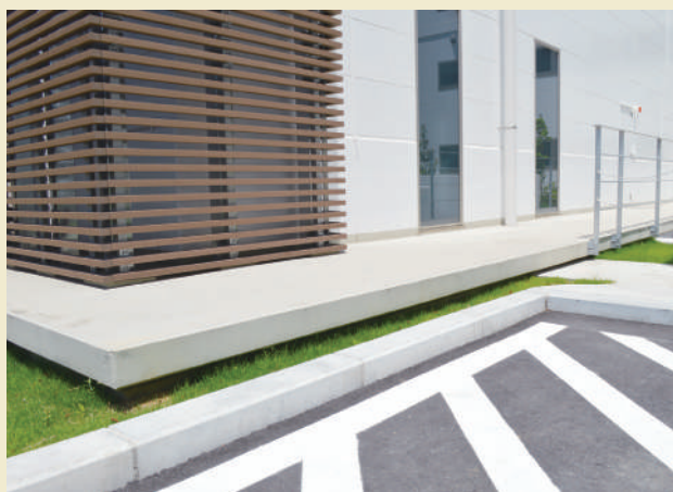
正面玄関横の免震クリアランス
