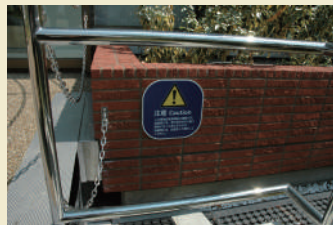
エキスパンションジョイント部分
