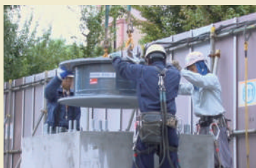
免震装置の据え付け
