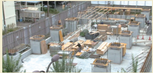
柱脚の上に取り付けられた免震装置
