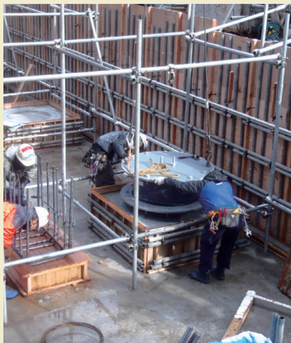
現場での据付工事の様子
