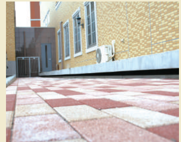
エキスパンションジョイント部
