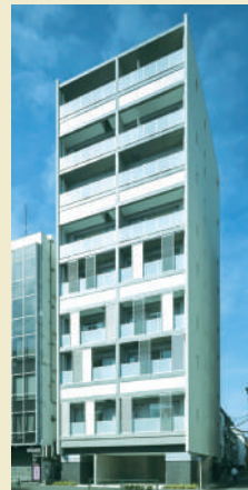
2014年10月竣工のRC造9階建
