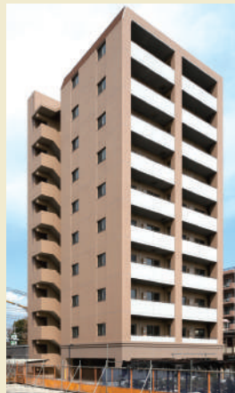
2011年3月竣工のRC造10階建
