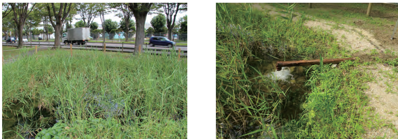
図11 池の上流に造成されたヨシ帯（左）と池水の循環システム（右）。
